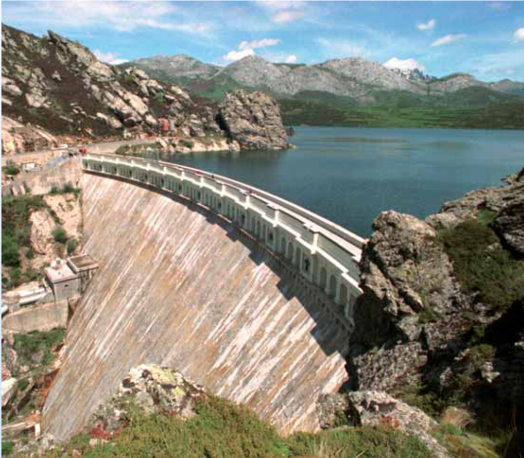
Presa de Camporredondo. Palencia
