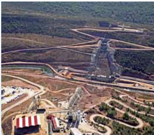
Visita Técnica Nº 1 - Presa de Castrovido. Burgos
