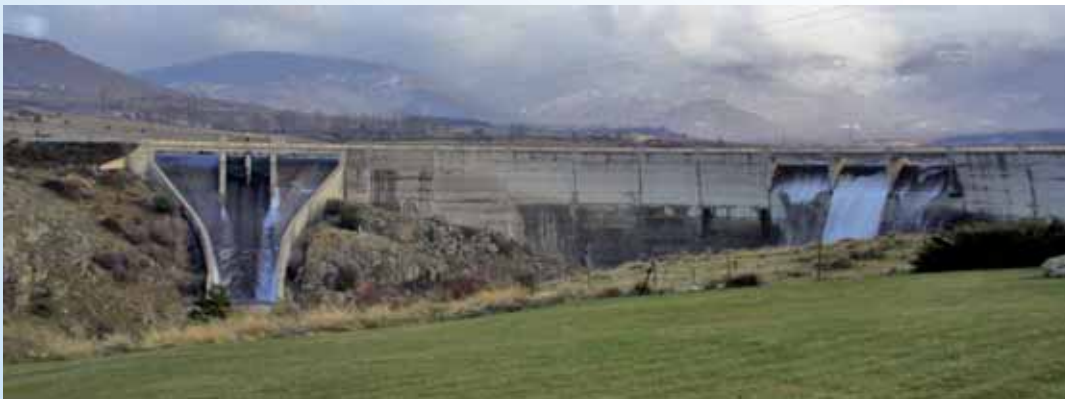
Presas de El Pontón Alto. Segovia
