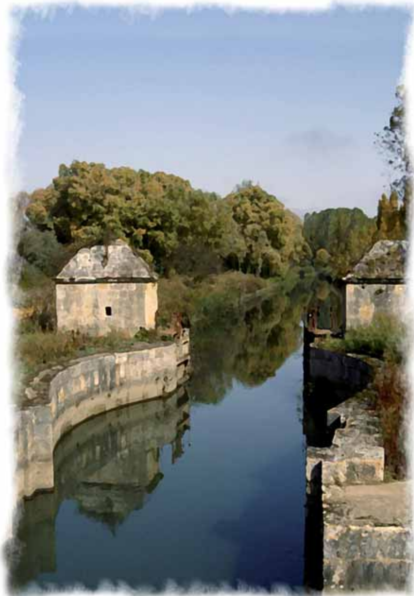
Esclusa de la Retención. Ramal de Campos PK 76+35. Canal de Castilla. Palencia
