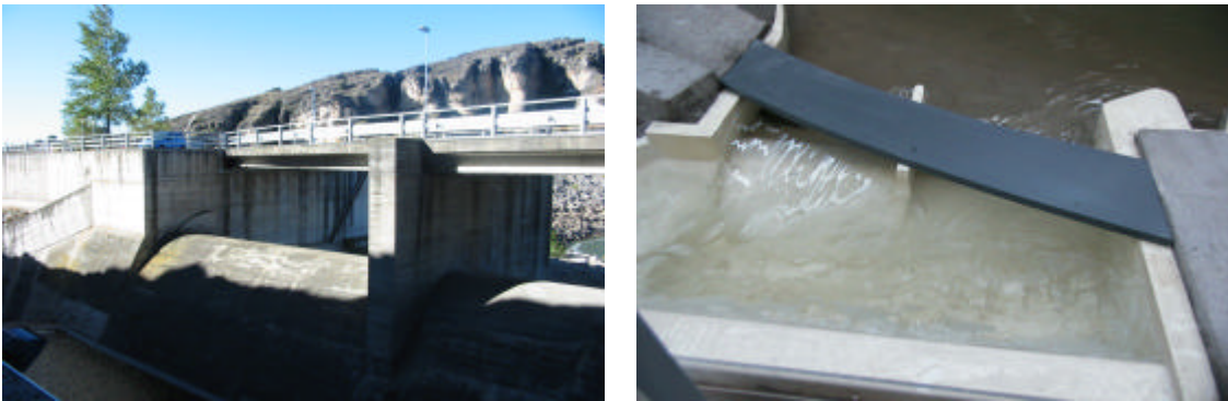
Aliviadero de la presa de Alcorlo (CH Tajo)
