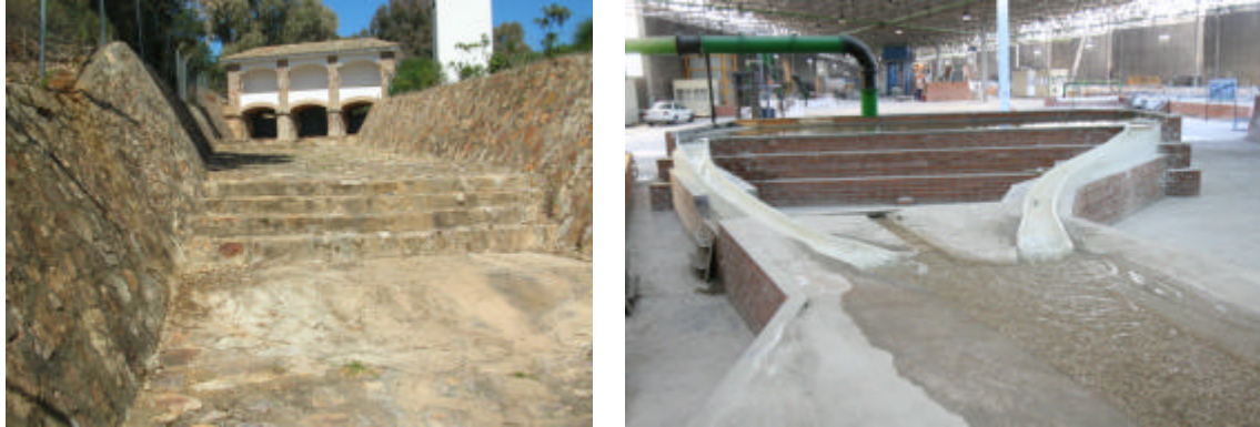
Aliviaderos de la presa de Gasset (CH Guadiana)
