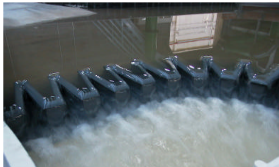
Aliviadero en laberinto en la presa de M a Cristina (CH Júcar)
