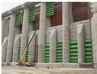
Compuertas de emergencia
