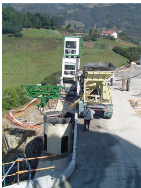
Ilustración 3: Muelle de cazos, silo-bus y cubo del blondín, durante la ejecución de las losas de ensayo
