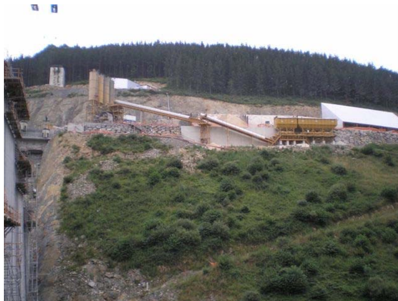
Ilustración 2: Instalaciones de fabricación del hormigón de la presa de Ibiur
