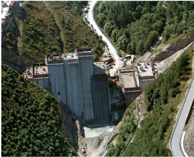
Ilustración 1: Bloques de la presa de Ibiur
