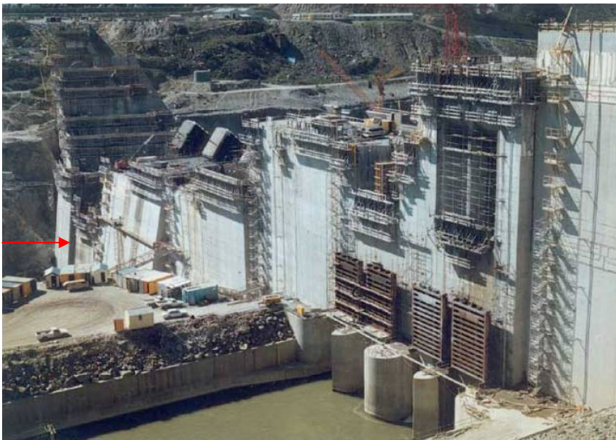
Presa de Clyde (Nueva Zelanda). Desplazamiento de la falla en el cauce
