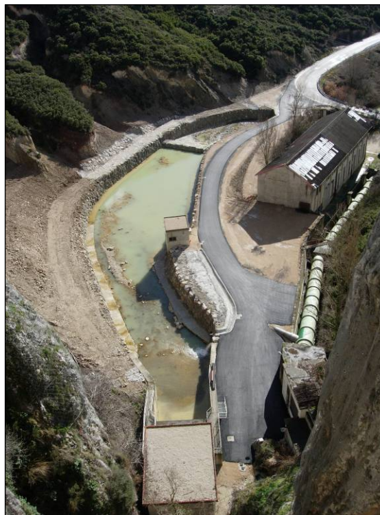
Fig. 5. Cuencos amortiguadores y canales de restitución del desagüe de fondo de la Presa de Allos. Estado actual.
