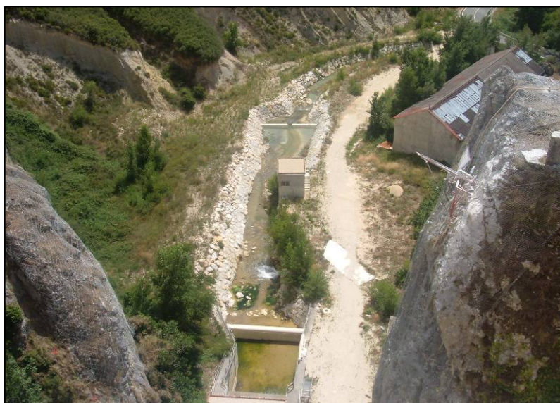
Fig. 3. Cuenco amortiguador y canal de restitución del desagüe de fondo de la Presa de Alloz previo a la actuación.
