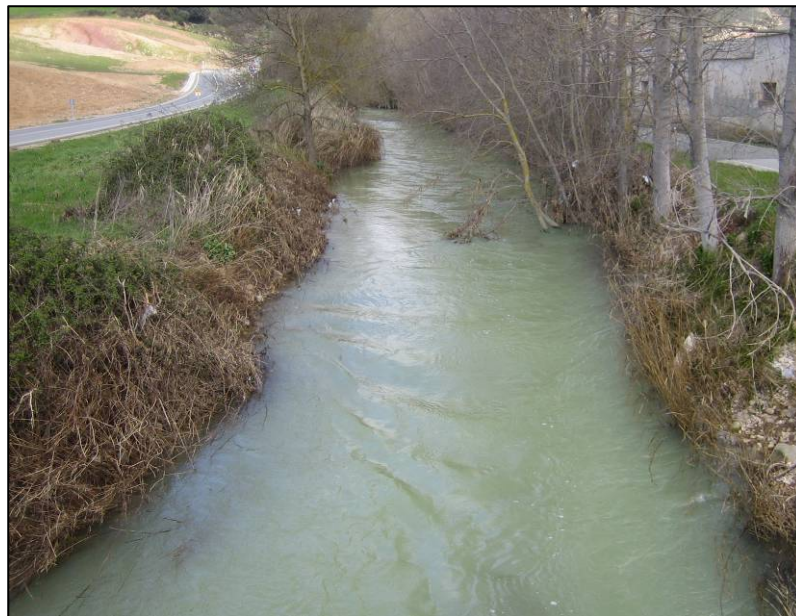
Fig. 7. Estado del cauce previo a la actuación. Vista hacia aguas arriba.
