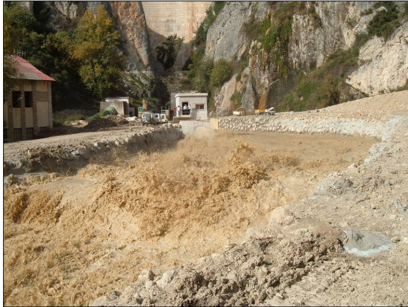
Fig. 6. Cuenco amortiguador tras la actuación, funcionando correctamente.
