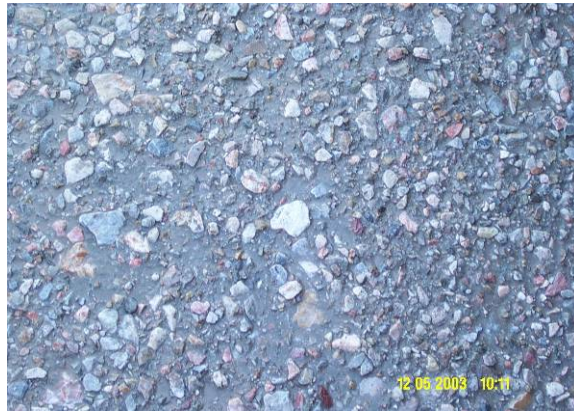
Foto 7. Superficie de una tongada bien descarnada con chorro de aire/agua a presión
