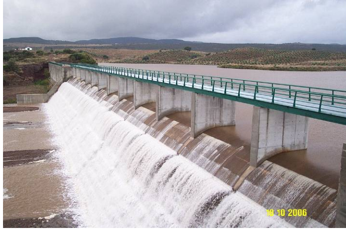
Foto 1. Presa HCR El Esparragal. Estribo derecho y aliviadero
