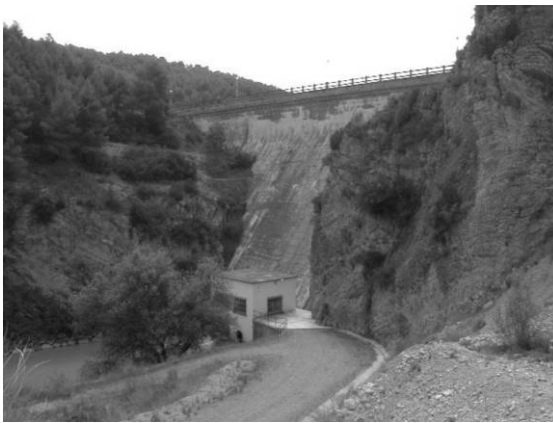
Figura 4.- Paramento de aguas abajo
