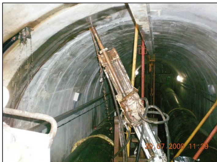
Foto: Perforación de taladros en abanico para sellado del contacto pantalla galería de desagüe de fondo.
