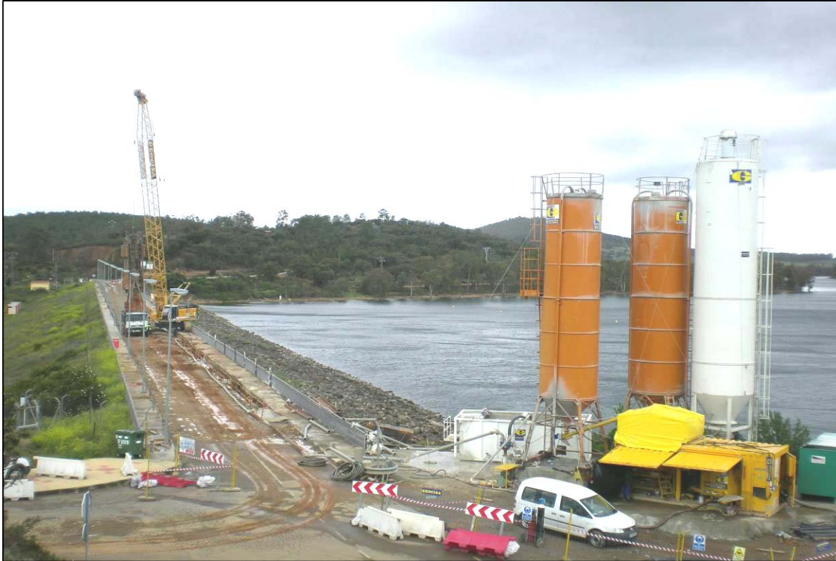
Foto: Instalación de fabricación de lodos y equipo de excavación.
