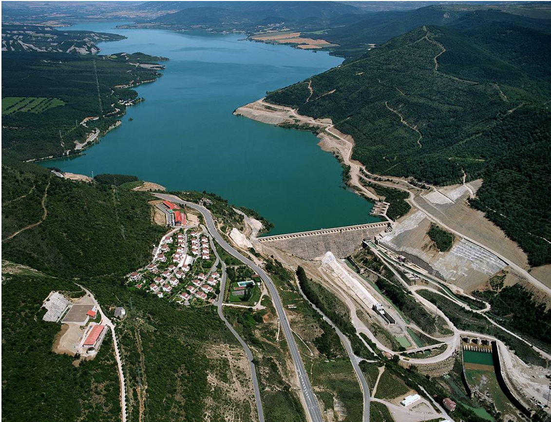
Fig. 4. Recrecimiento de la presa de Yesa (junio 2008)
