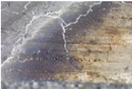
Fig. 3: Bordes con deposiciones salinas
