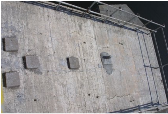
Fig. 1: Fisuración mapeada.
