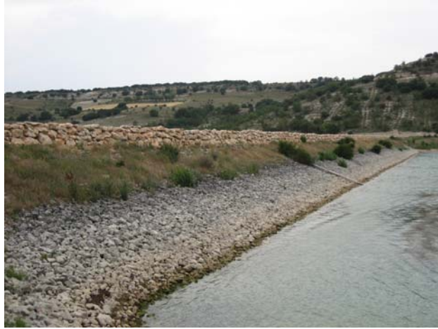
Fig. 14: Recrecimiento del dique con escollera (Obra terminada)
