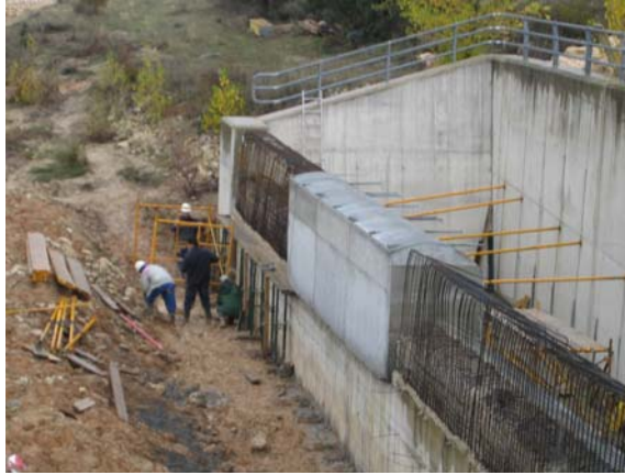
Fig. 11: Recrecimiento aliviadero (Ejecución de obra)
