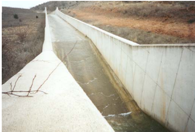
Fig. 6: Vista del canal de descarga desde aguas abajo de la presa
