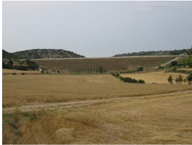
Fig. 15: Vista panorámica dique recrecido (Obra terminada)
