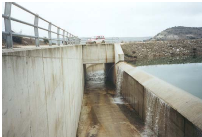
Fig. 4: Aliviadero. Cuenco de recepción de la presa (antes de recrecimiento)
