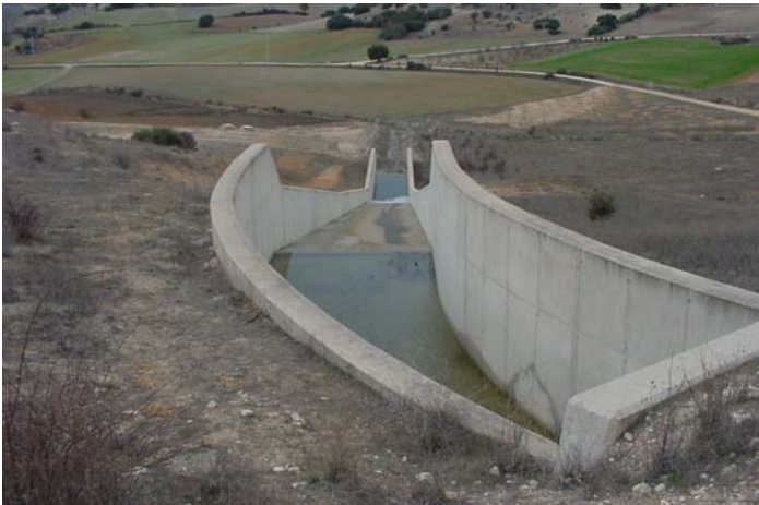
Fig. 7: Estanque amortiguador de la presa
