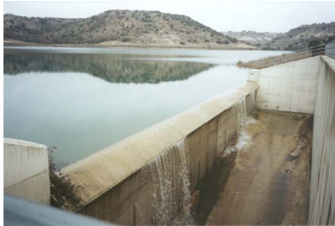
Fig. 9: Aliviadero vertiendo (situación anterior a la obra)
