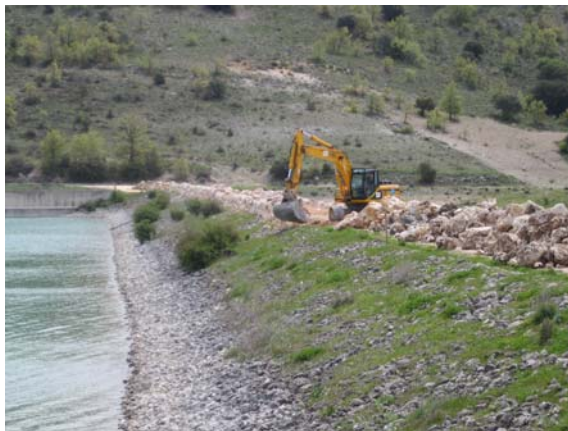
Fig. 13: Recrecimiento del dique con escollera (Ejecución obra)
