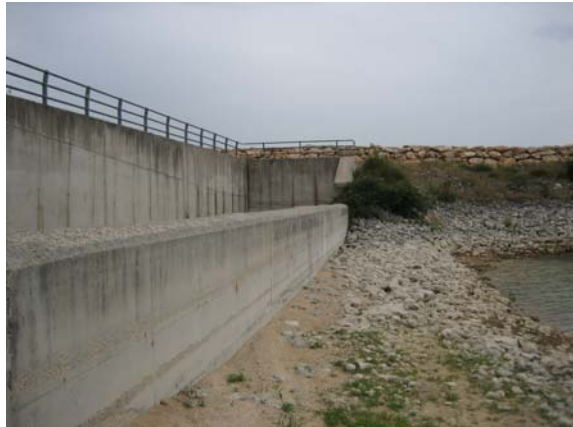
Fig. 12: Aliviadero recrecido (Obra terminada)
