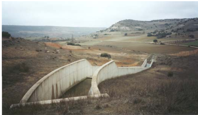
Fig. 5: Vista del canal de descarga desde coronación de la presa
