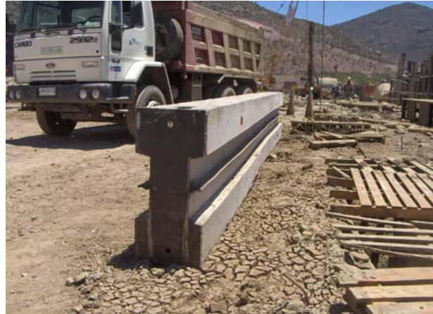
Fig. 16 Elemento de impermeabilización de juntas entre bataches de pantalla
