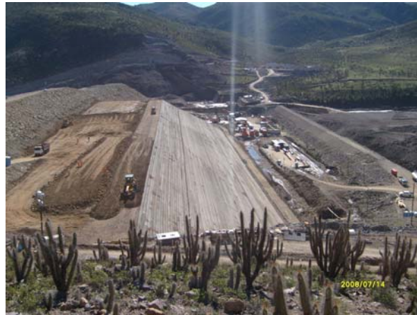
Fig. 3 Vista general de la presa en construcción (Julio de 2008)
