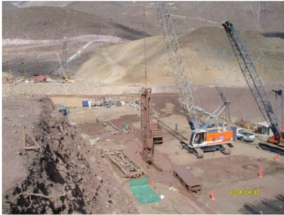
Fig. 15 Ejecución de la pantalla de impermeabilización del aluvial
