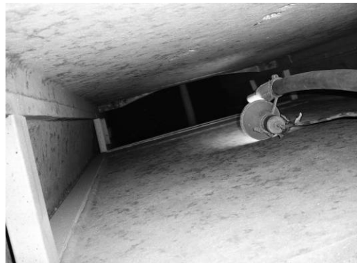
foto 7: Buzón de compuerta después del granallado.
