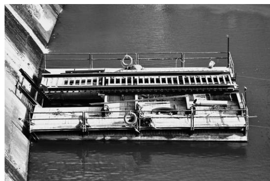
foto 3: Pontona para traslado de equipos por el cuenco amortiguador.
