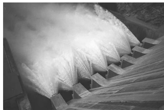
foto 5: Desagües de fondo abiertos simultáneamente el día de la recepción de la obra.
