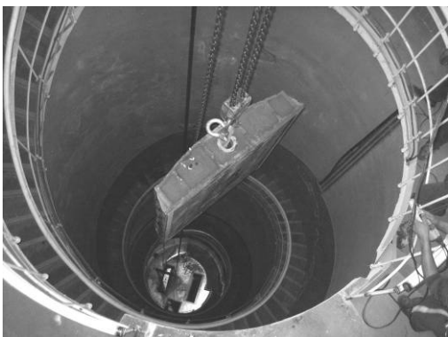
foto 8: Bajando obturador reparado por pozo de compuertas.
