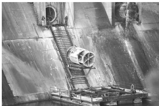
foto 2: Descenso a pontona de HB antigua una vez separada del cuerpo de presa.
