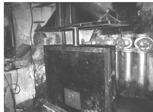
foto 9: Calando obturador en cuerpo de compuerta.
