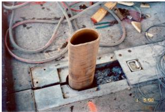
Figura 6. Vista de la junta estanca después de ser instalada (Presa Chickamauga, Tennessee, USA)
