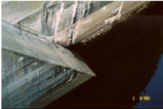
Figura 5. Vista de la ranura sin agua, después de rellenar con agua la junta estanca, en la presa Chickamauga, Tennessee, USA
