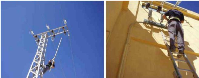
Mantenimiento y reparación de centros de transformación
