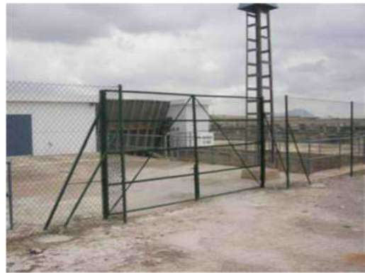
Vallado de las instalaciones del canal de Abanilla.
