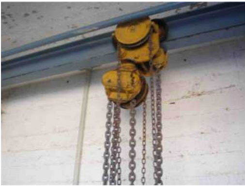
Sustitución del polipasto y viga carril. Embalse de Argos
