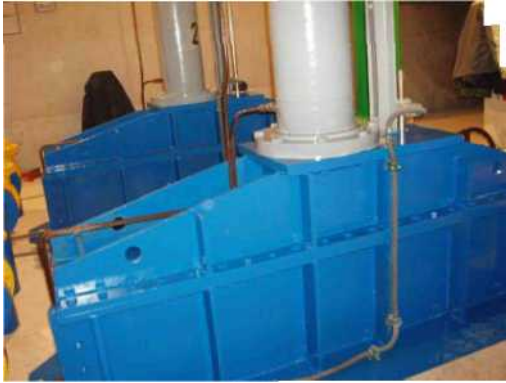
Tratamiento de pintura de órganos del desagüe de fondo del embalse del Judío, y llenado del circuito hidráulico
