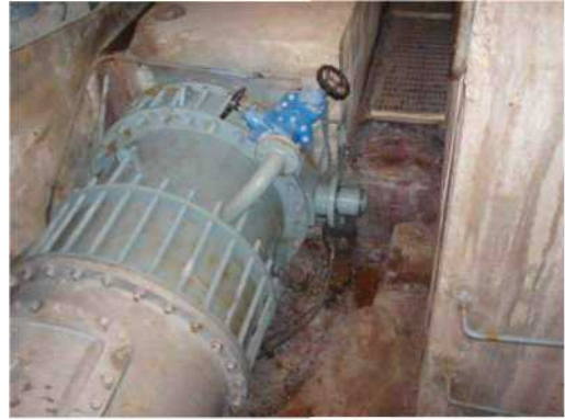
Cambio de la válvula mariposa toma de agua cota 395, embalse de Argos
