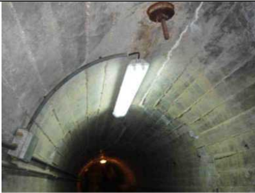
Refuerzo de alumbrado normal y emergencia en galerías de embalses.
