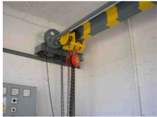
Estado reparado. Embalse de Argos
