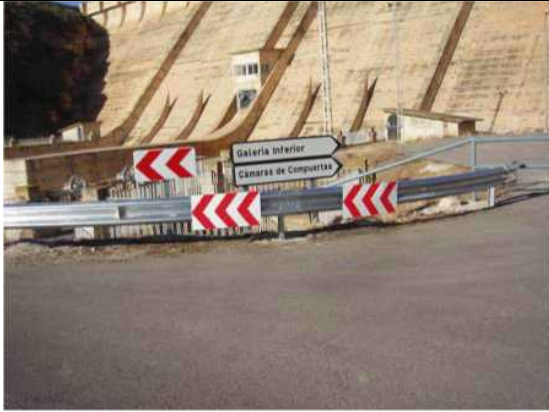
Biondas y señalización vial en embalse de Santomera
