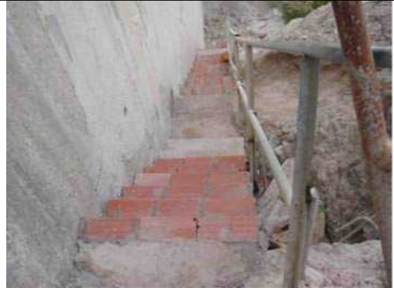
Rehabilitación escalera bajada al pie de presa. Puentes IV
