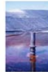
Fotografía 18 - Desagüe de fondo. Acople documentado para despiece de la balsa. Balsa de Mayas del Egipto (Líbano)
