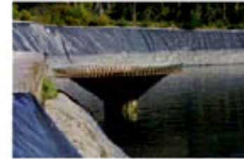
Fotografía 11 Aliviadero Morning Glory en granito
