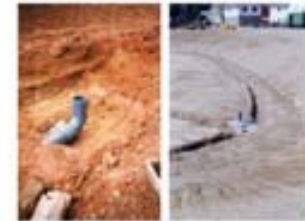
Fotografía 17 - Desagüe de fondo en construcción y finalizado. Balsa de Yompa y de Balsa (Líbano)
