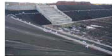
Figura 1 Canal de entrada escalonado
