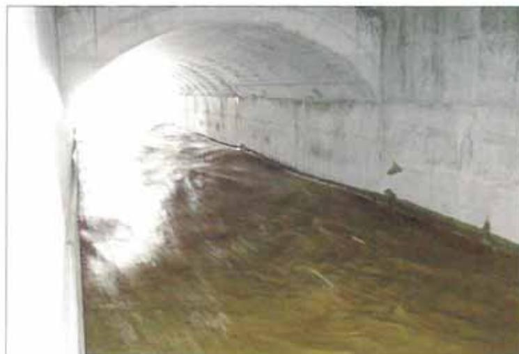
Fig. 11. Túnel de desvío en funcionamiento con importantes caudales.
