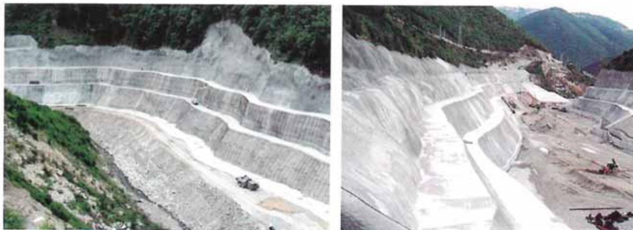
Fig. 34. Sellado en el cauce y taludes del río Gashnya en la conexión con el río Vacha.
