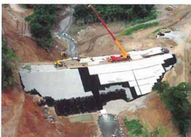
Fig. 25. Atagüia. Manto de bloques y ductos de desvío.
