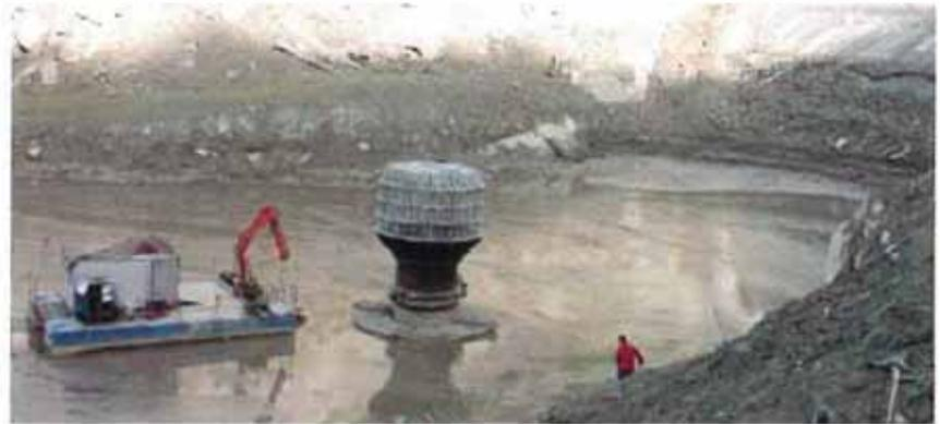
Fig. 15. La toma de agua de la presa Alesani en Francia está obstruida por sedimentos hasta 2/3 de su altura. A la derecha, Fig. 16. Nueva torre de toma de la presa Alesani en Francia.
