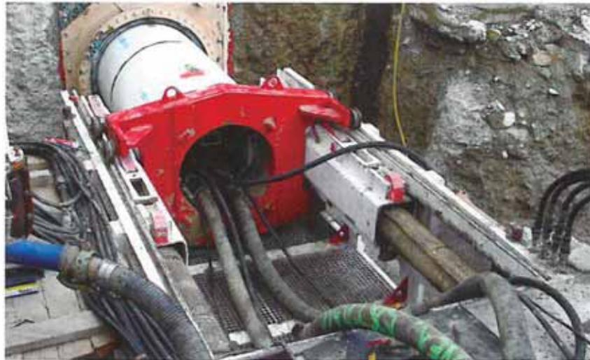
Fig. 1. Fotografías de la ejecución del desagüe de fondo en la presa de la Jarosa (Canal de Isabel II).
