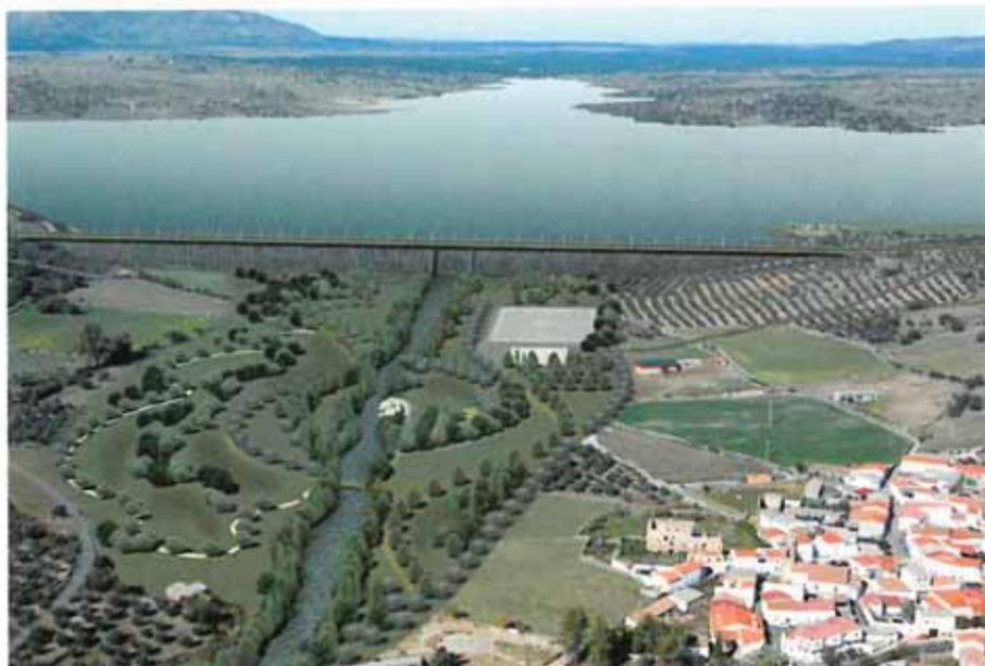
En cuanto a la inclinación de sus taludes se proyecta vertical aguas arriba y 0,80 (H)/1 (V) aguas abajo, suma de taludes ligeramente más reducida de lo
