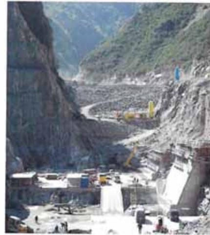
Fig.39. Creación de cuenco de disipación de energía para el vertido directo desde el aliviadero.
