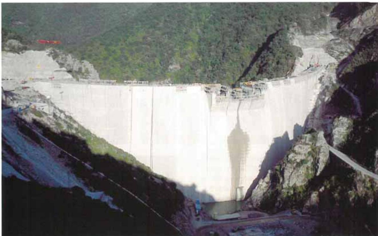
apoyo en los estribos y se ha ampliado la profundidad de excavación hasta obtener parámetros de suficiente calidad. En cuanto a la deformabilidad del macizo rocoso, aunque una estructura en arco es hiperestática y admite cierta deformación del cimiento, se requiere un tratamiento de consolidación del mismo para aumentar su módulo de deformación.
