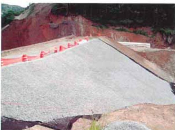
Fig. 24. Atagüia. Lámina y manto de gravas para colocación de bloques.
