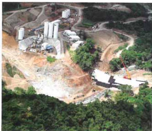
Fig. 29. Disposición de la planta en la margen derecha y la ataguía.
