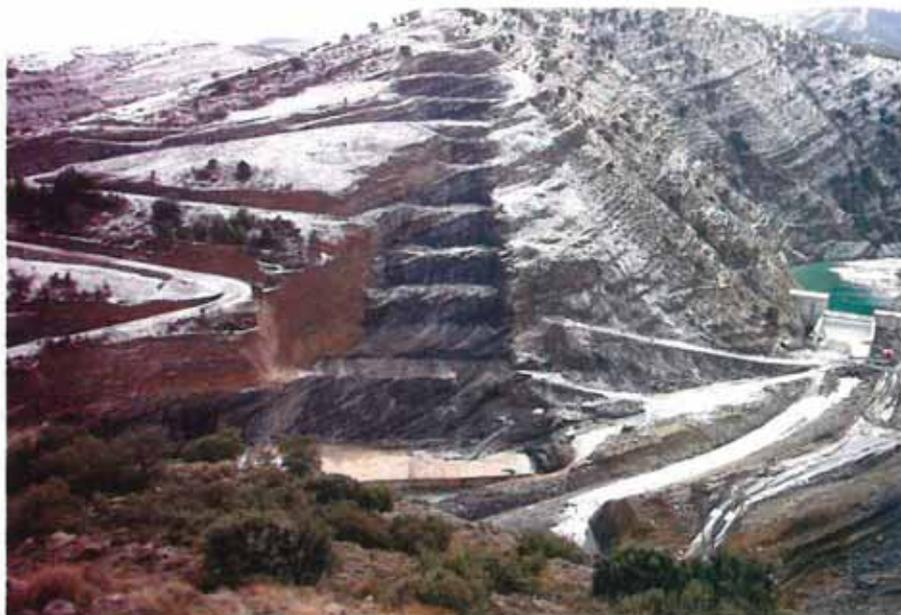
arranca el talud teórico del paramento de aguas abajo que es del 0,8H:1,0V. Los taludes del paramento de aguas abajo se realizarán escalonados con escalones de 1,20 m de alto por 0,96 m de ancho. El paramento de aguas arriba es vertical. La coronación tiene una anchura total de 8,00 m, distribuidos en una calzada
