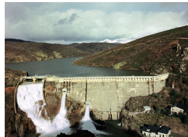
Presa de Requejada
