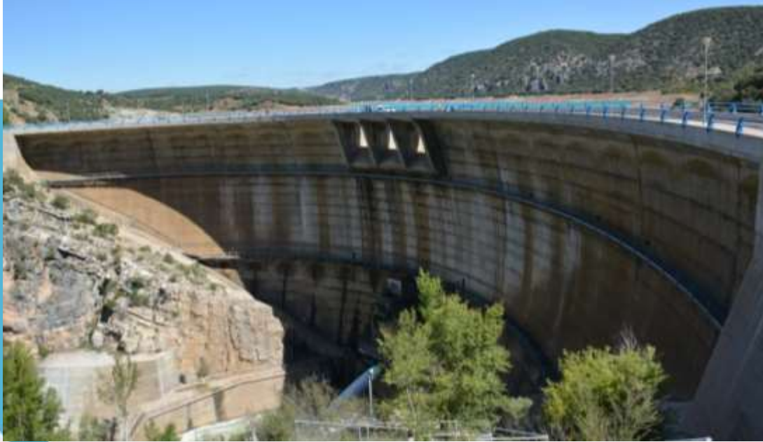
Presa de La Tajera
