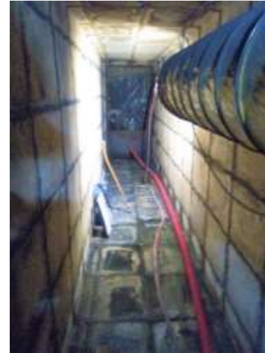
Retirada entramado combinando Hidrodemolición y corte
