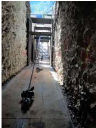
Entrada piezas en “U” por arrastre. Colocación
