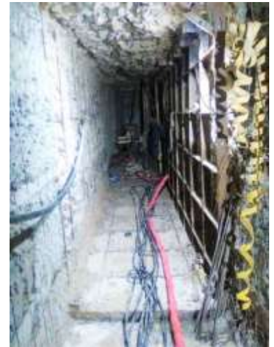
Retirada entramado combinando Hidrodemolición y corte
