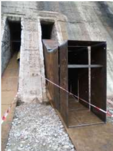
Entrada piezas en “U” por arrastre. Colocación
