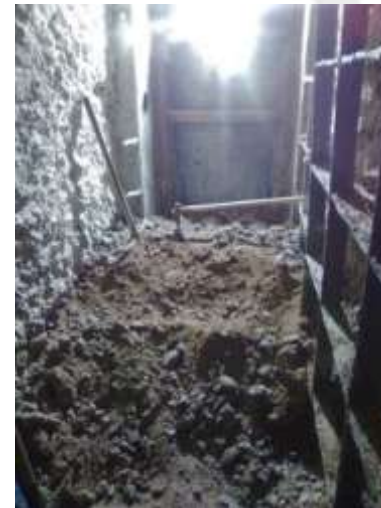
Demolición y residuo
