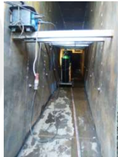
Blindaje anclado y soldado
