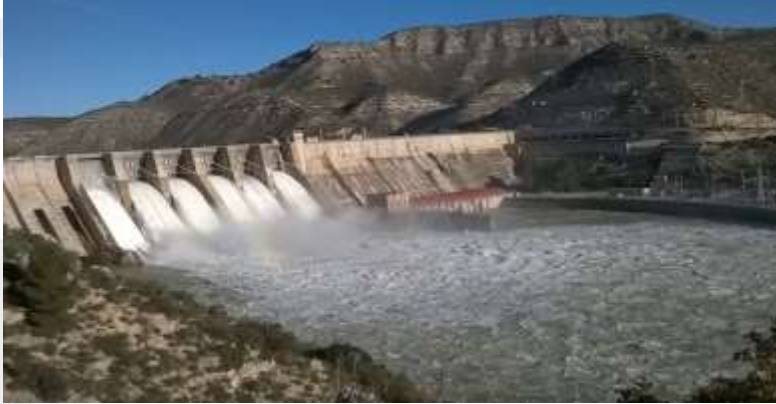
PRESA DE MEQUINENZA
