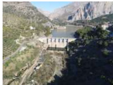
Presa Tajo de la Encantada
