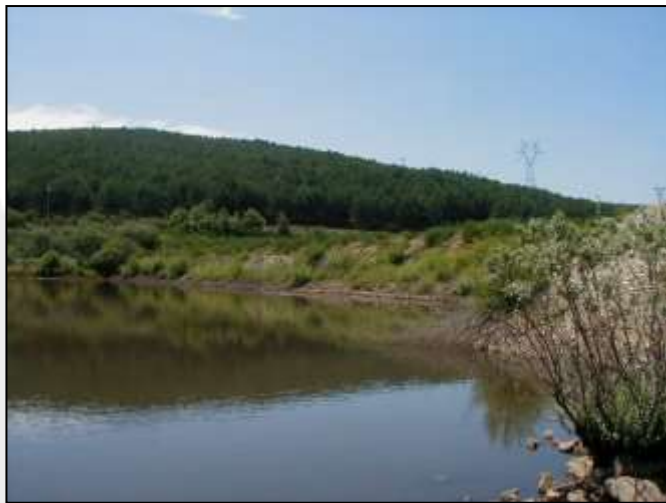
Dique de cierre
