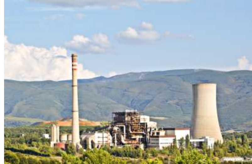
Central térmica de Anllares
