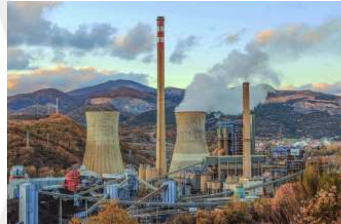
Central térmica de La Robla
