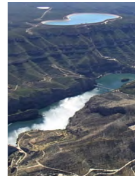
Cortes-La Muela I + II. 1482 MW, 24 GWh. L/H muy reducido 3-4. Fuente: Iberdrola.
