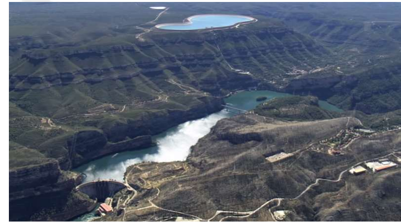
Cortes-La Muela I + II. 1.772 MW. España
