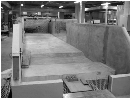
Foto N°1 Recinto de ensayos
