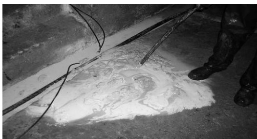
Fig. 8. Extracción del detritus depositado en el fondo del dren tras la limpieza. Se aprecia la gran cantidad de materia sólida que se consigue desprender y eliminar del dren.
