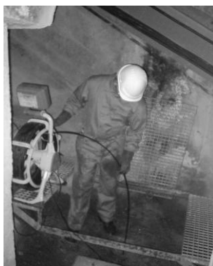
Fig. 9. Introducción de la manguera con mini cámara en un dren para su inspección
