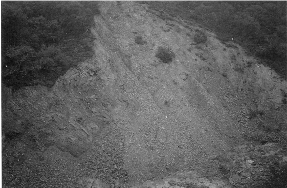
Detalle del corrimiento de ladera existente entre los P.K. 0+300 y 0+400, como consecuencia de la socavación producida por las aguas sobre el pie del talud.
