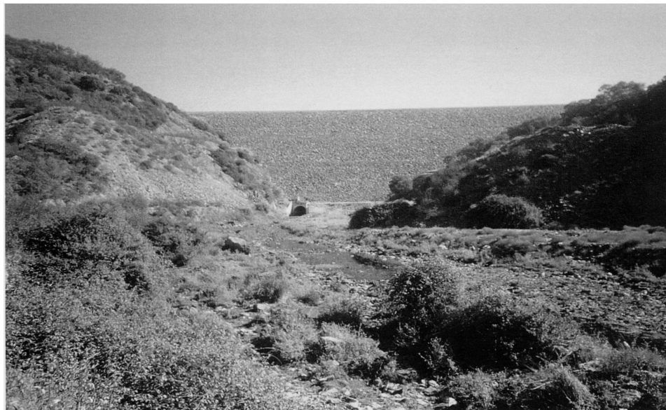
Vista general de la presa por aguas abajo. La galería de los desagües de fondo queda situada en margen derecha a cota del cauce.
