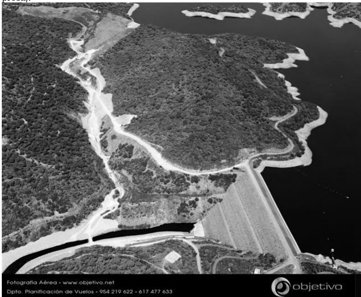
Vista general del barranco del Carbonero. Cuerpo de presa y riera de Huesna en parte inferior. Trinchera entre vertedero y barranco en parte superior izquierda.
