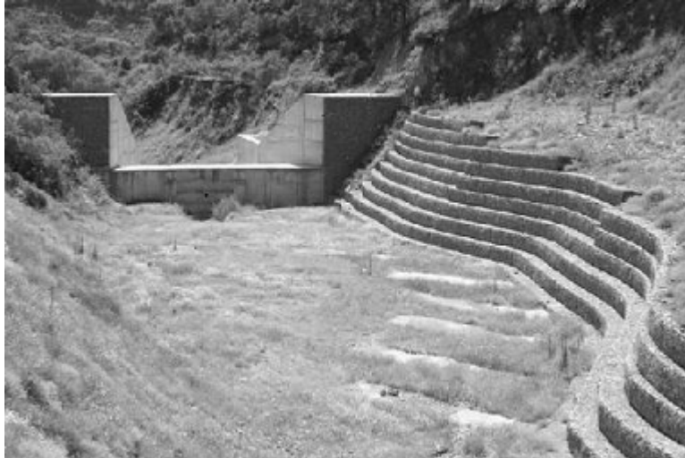
Zona aguas arriba Azud 1
