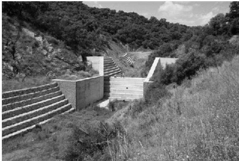
Zona aguas abajo Azud 1
