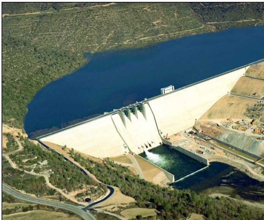
Imagen 1: Presa de Rialb. Vista general desde aguas abajo.
