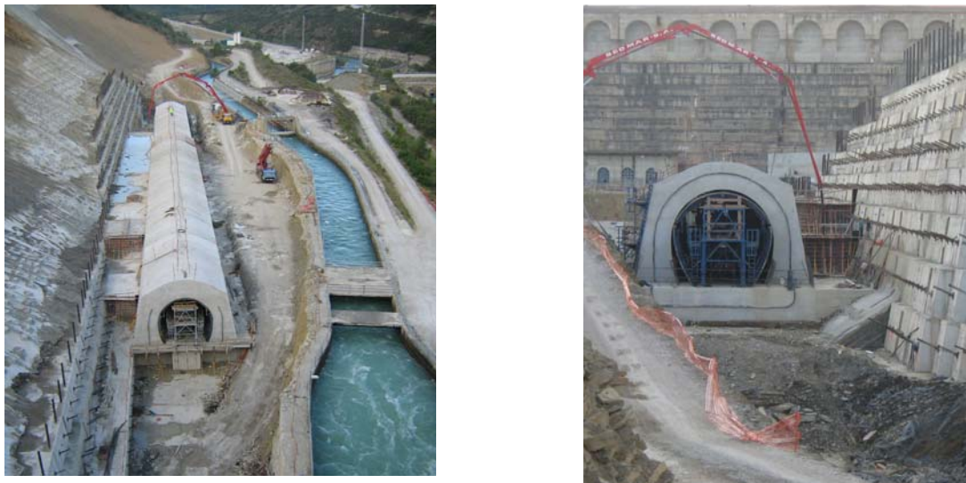
Fig. 6. Obras de la toma de Bardenas (septiembre 2008)
