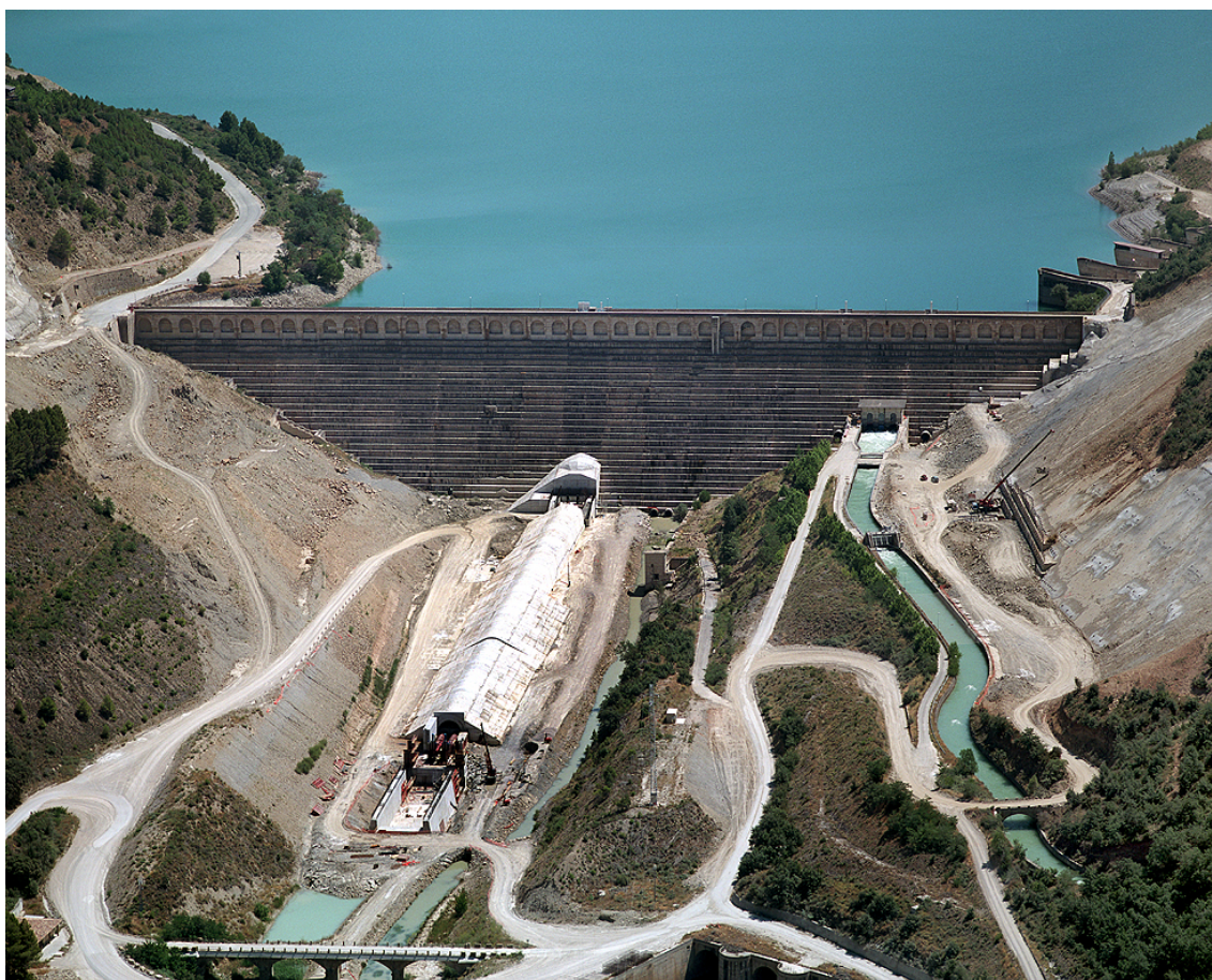
Fig. 5. Obras del desagüe de fondo (julio 2007)
