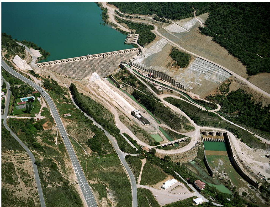
Fig. 8. Obras del recrecimiento de la presa de Yesa (junio 2008)
