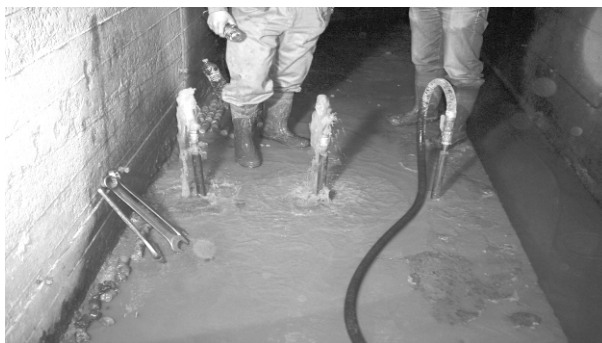
Fig. 7: Detalle comunicación entre taladros
