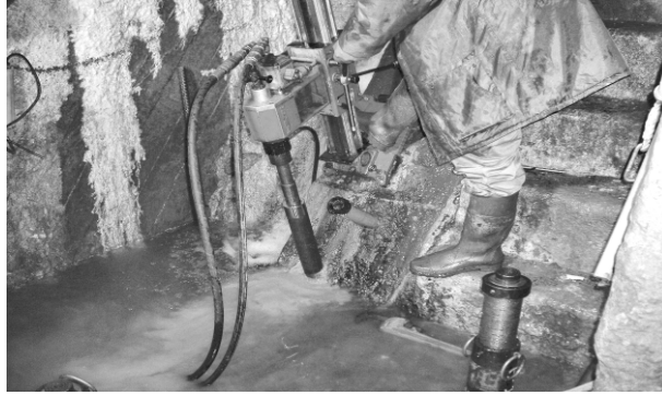
Fig. 8: Perforación de taladro de Ø 76 mm
