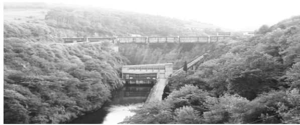
Fig. 1: Imagen de la presa de Doiras desde aguas abajo
