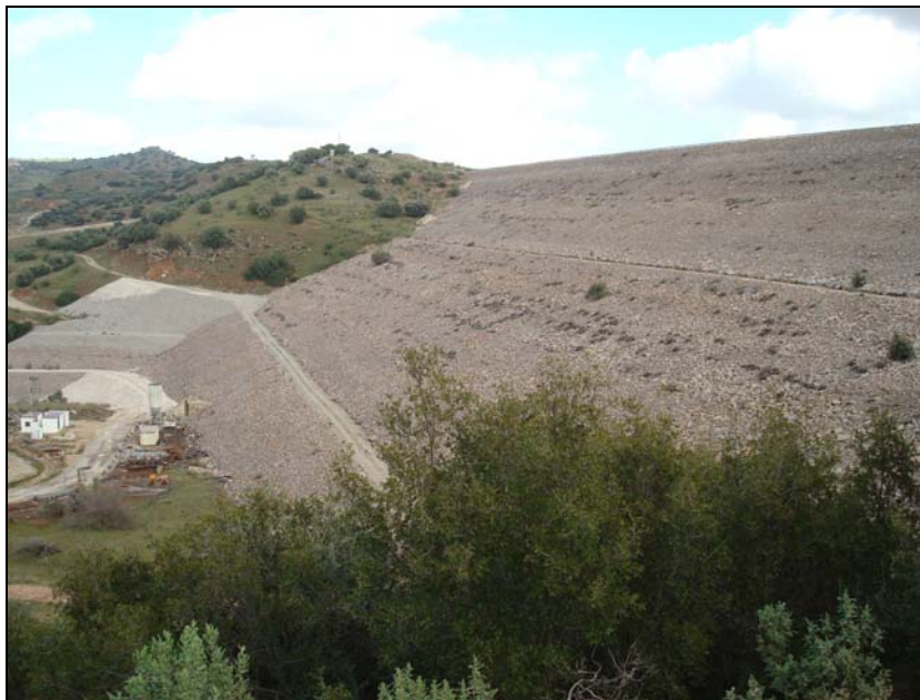
Foto 3.- Filtro invertido en margen derecha. Giribaile
