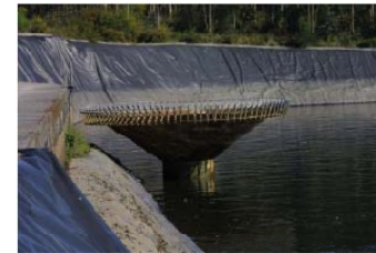
Fotografía 11 Aliviadero Morning Glory en ejecución
