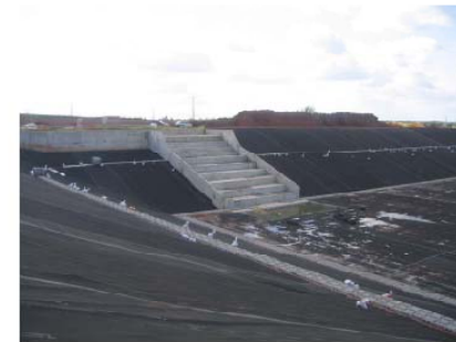
Fotografía 1 Canal de entrada escalonado
