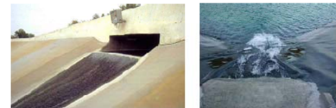
Fotografía 4 Entradas de agua mediante arqueta de hormigón sobre la lámina con rebaje del talud
