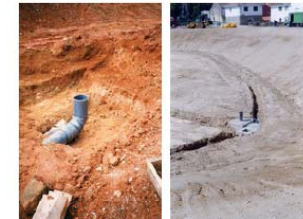
Fotografía 18 Desagües de fondo, en construcción y finalizado. Balsas de Navatejares y de Bohoyo (Ávila)
